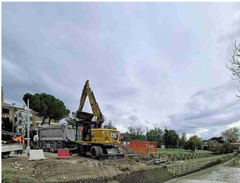
Lavori in corso vanno avanti le operazioni per ripristinare il Canale del Reno, invaso dai detriti (foto Consorzio canali di Bologna)
