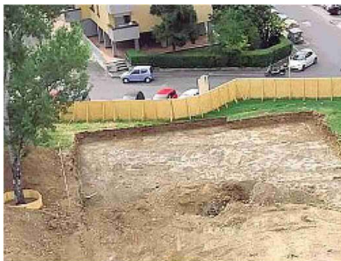
Cantiere I lavori in corso nel giardino Acerbi dove sorgerà il nido Cavazzoni
