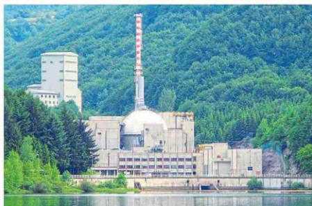
▲ Centrale Enea del Brasimone: 11 milioni Riqualificazione del sito e della stazione
