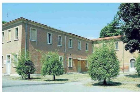
▲ Polo dell'Osservanza a Imola: 15,2 milioni Rigenerazione di parte dell'ex complesso
